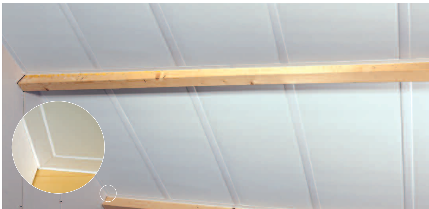
Hoekoplossing met in verstek gezaagde profielen.
