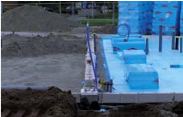
Vloerisolatie direct op de grond
