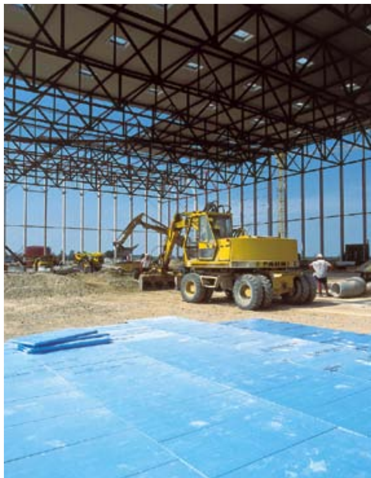
Isolatie onder de draagvloer
