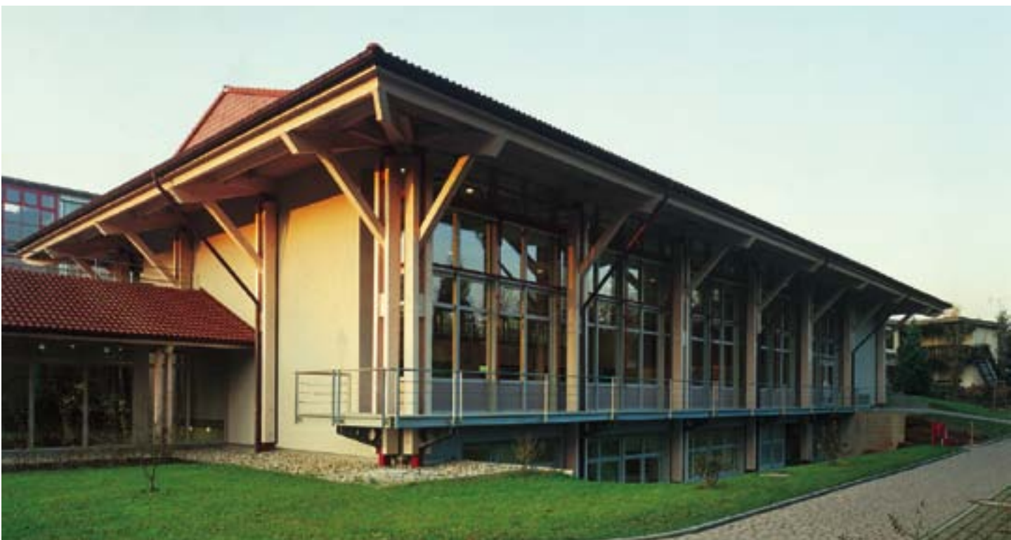
Kelderisolatie toegepast aan buitenzijde verwarmde ruimte
