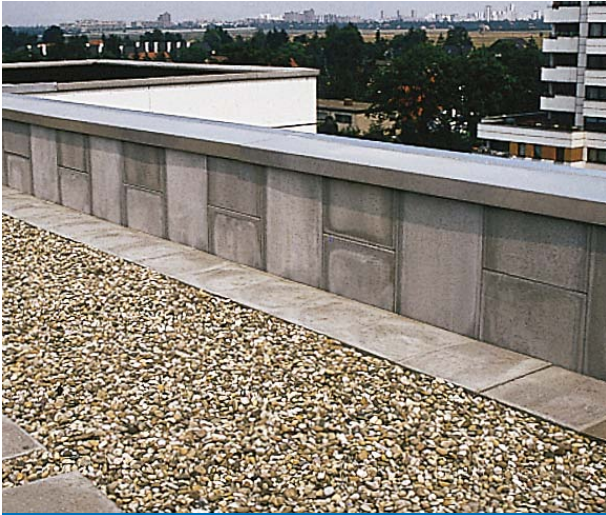
Dakrand-opstand geïsoleerd met ROOFMATE LG
