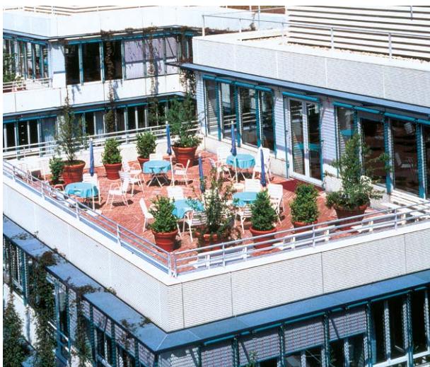
Omkeerdak uitgevoerd als terrasdak
