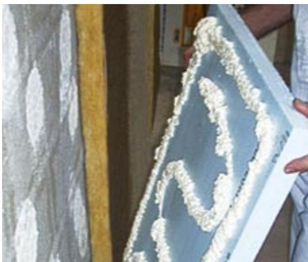
INSTA-STIK aangebracht op isolatieplaat voor verticale bevestiging
