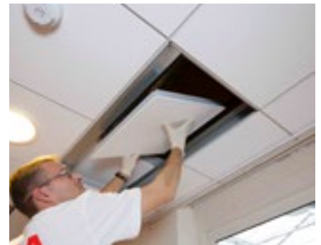
↑ De extreem brandwerende 2resist-plafondpanelen beschermen de bovenliggende constructie en installaties.
