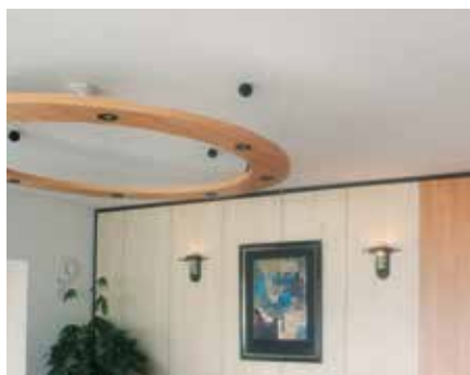
↑ GP22 VO in vergaderruimte.
