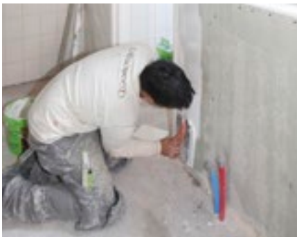
↑ De naden tussen de wandpanelen zijn volkomen vlak af te werken.
