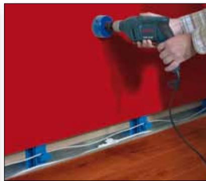
Het gat voor het elektra aansluitpunt op de gewenste plaats boren
