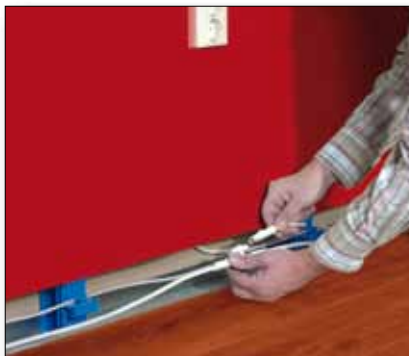
De kabel aansluiten op de stekkerdoos
