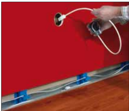
De kabel doorvoeren en de wandcontactdoos monteren
