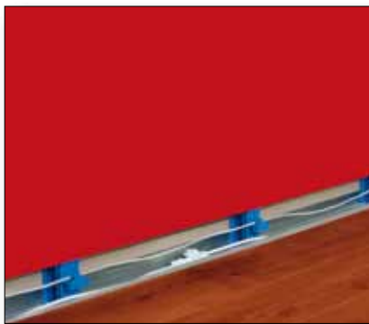
De plint demonteren
