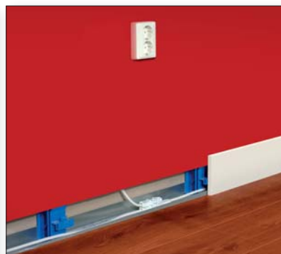
De plint weer bevestigen; aansluiting gereed
