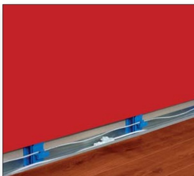
De plint demonteren
